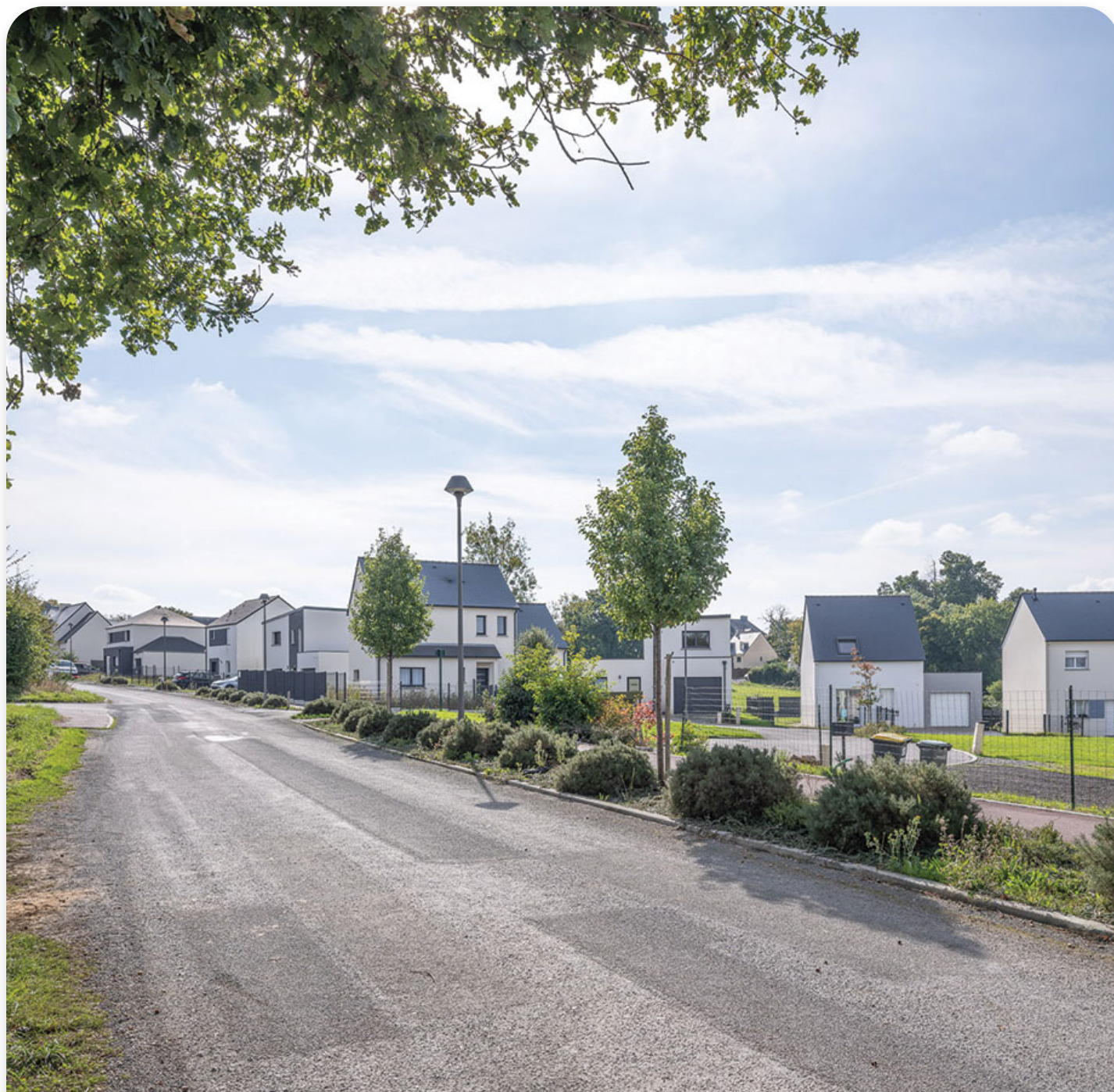
Opération d'aménagement Viabilis à Treffendel © Dimitri Lamour
